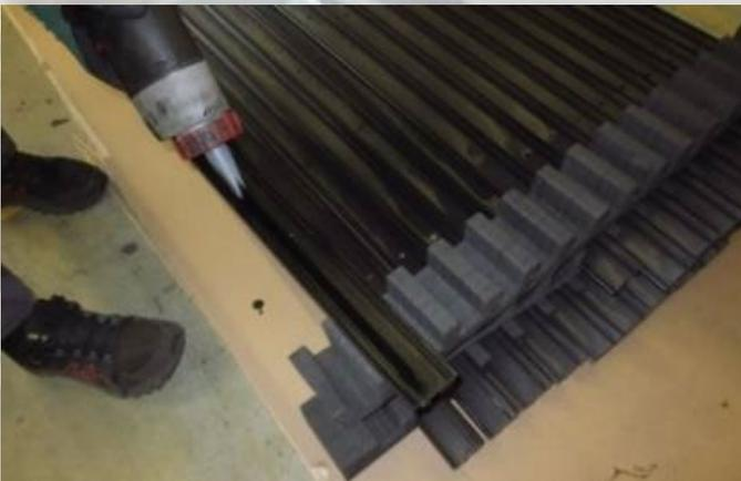
Tragen Sie auf die Halterungsteile und auf die Schiene den Sika Tack Elite auf. Ref: 2852594, Pistolet: Ref. 2852631, Endstück: Ref. 2852653. Zeit 10Min stehen lassen
