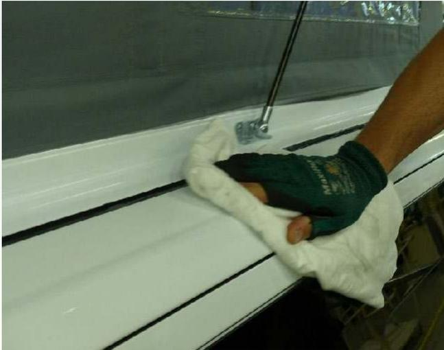
Das Dach in dem Bereich wo die Schiene montiert wird mit Isopropylalkohol gründlich reinigen.
