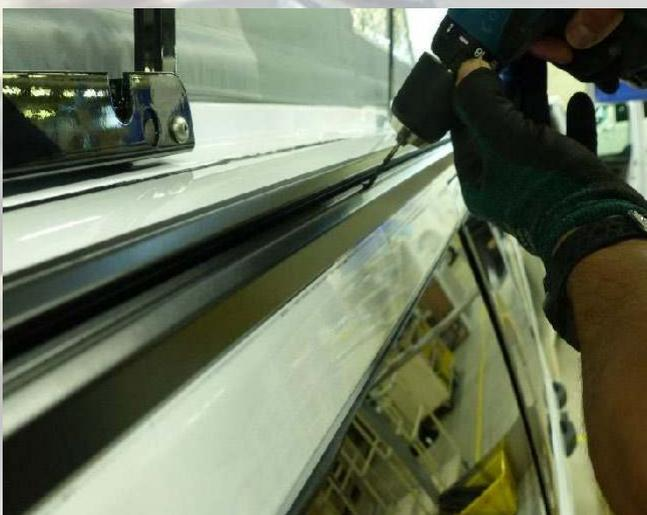
Mit dem 3mm Bohrer die anderen 3 Löcher bohren und auch verschrauben. Danach muss mindestens eine **Trocknung von 35 min** gegeben sein bevor die Markise montiert werden kann.
