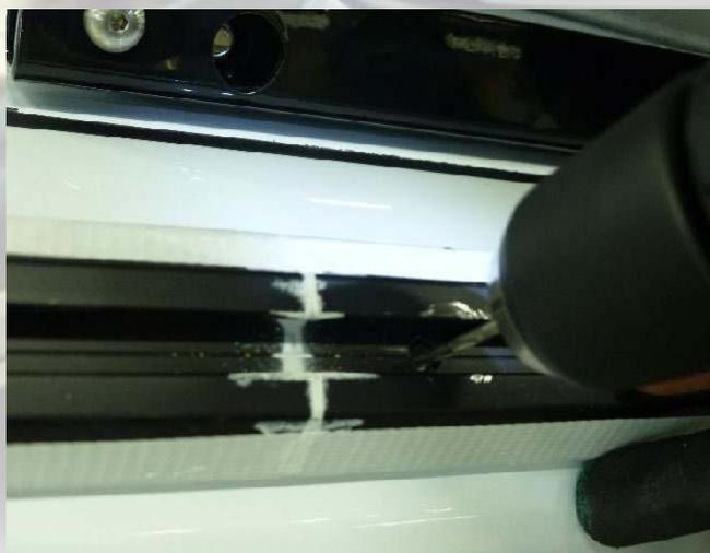
Das erste und das Letzte Loch mit einem 3mm Bohrer vorbohren.
